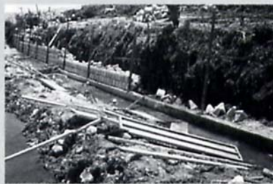
写真② 積みあげられるブロック
