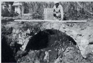
写真③ アーチ型の古い石橋
