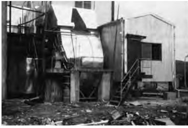
写真1 第二工場の集塵装置
