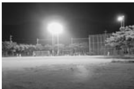
西原中学校の夜間照明施設
