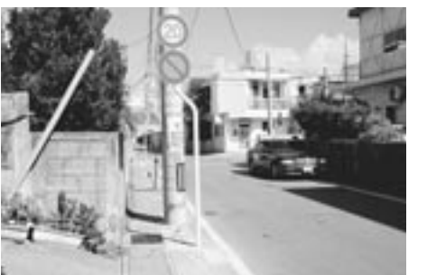
改善が必要な狭い歩道
