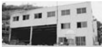
柵原医療産廃処理施設跡
