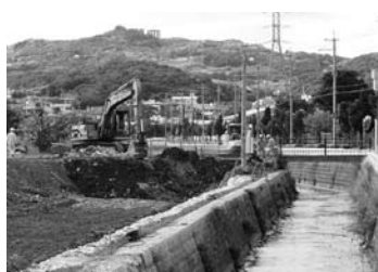
小波津川暫定掘削工事
