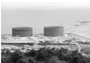
建設中の吉の浦発電所
