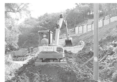
桃原・池田線の工事
