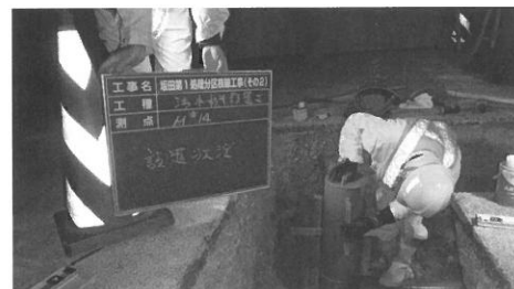
下水道工事のようす (イメージ)
