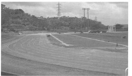
一括交付金事業を活用して整備中の陸上競技場
