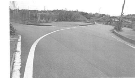
小波津5号線に設置された外側線
