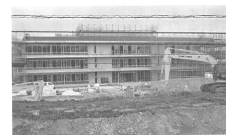
着々と建設が進む新庁舎複合施設
