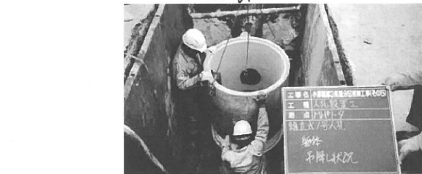
下水道工事のもよう
