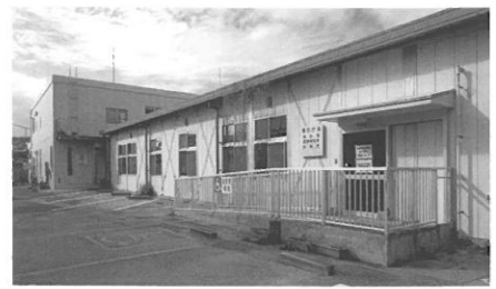
旧役場の第5庁舎(後ろは第3庁舎)
