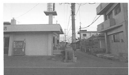
交通の障害となっている電柱(小波津区)
