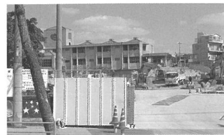
新增改築中の坂田小学校
