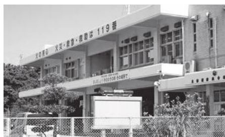
建築後36年が経過した東部消防組合本部庁舎
