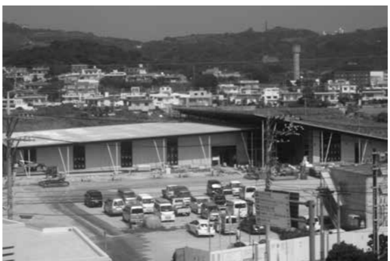
工事が進む西原さわふじマルシェ
