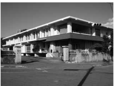
▲築35年が経過する給食センター
