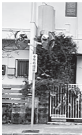
設置完了したカーブミラー
