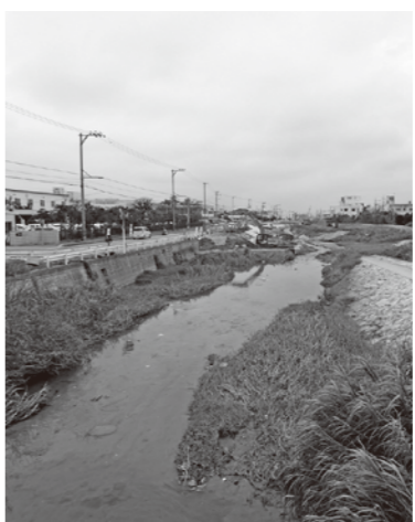
改修工事が進む小波津川
