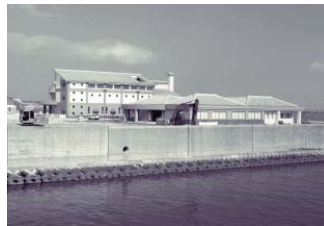
西原浄化センター
