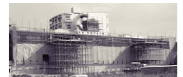
建設中の坂田保育所・児童館
