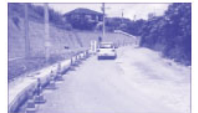
会長・上原線の繰越道路工事
