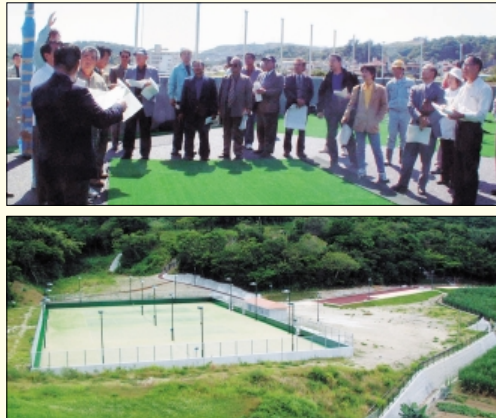
運動公園テニスコート造成現場
