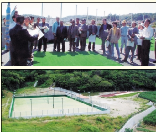
運動公園テニスコート造成現場
