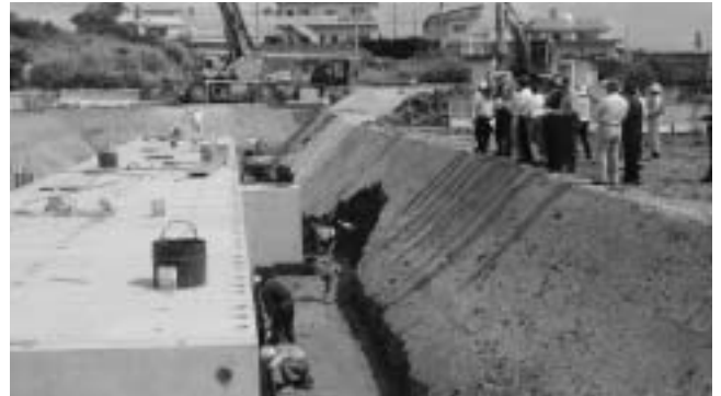
完了間近の津花波地区排水整備(地下タンク)を視察
