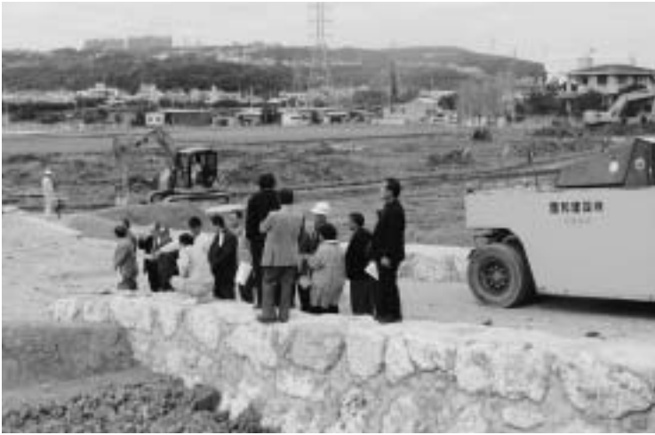
安室地区ほ場の工事現場
