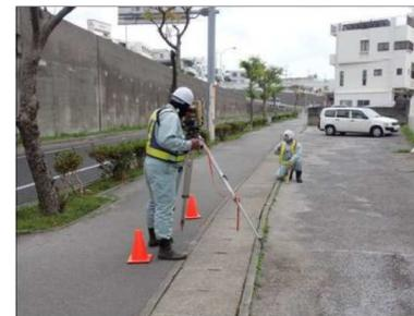
T S 測量機器及び電子平板による測量作業状況
