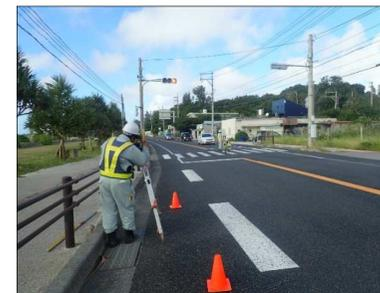
T S 測量機器による測量作業状況
